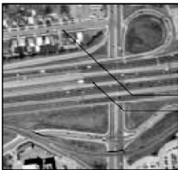
خیابان و مجتمع های مسکونی بزرگراه چند باند
